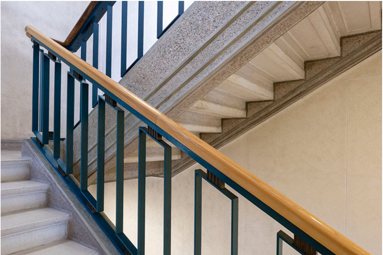
Rez-de-chaussée, corps central : rampe de l'escalier.
