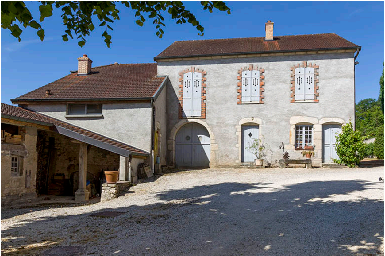
Vue générale de la ferme depuis l'entrée.
