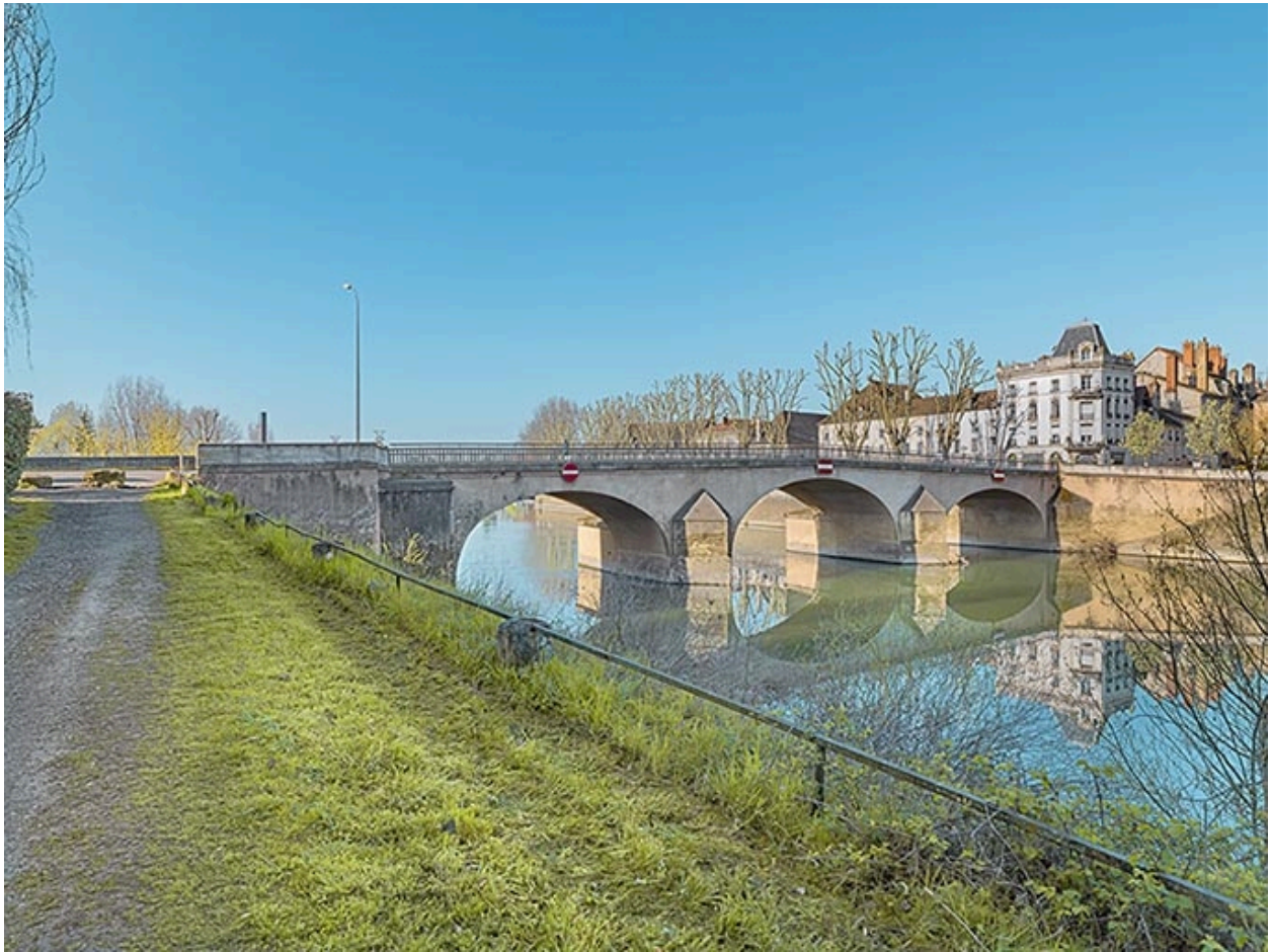
Vue d'ensemble du pont.
