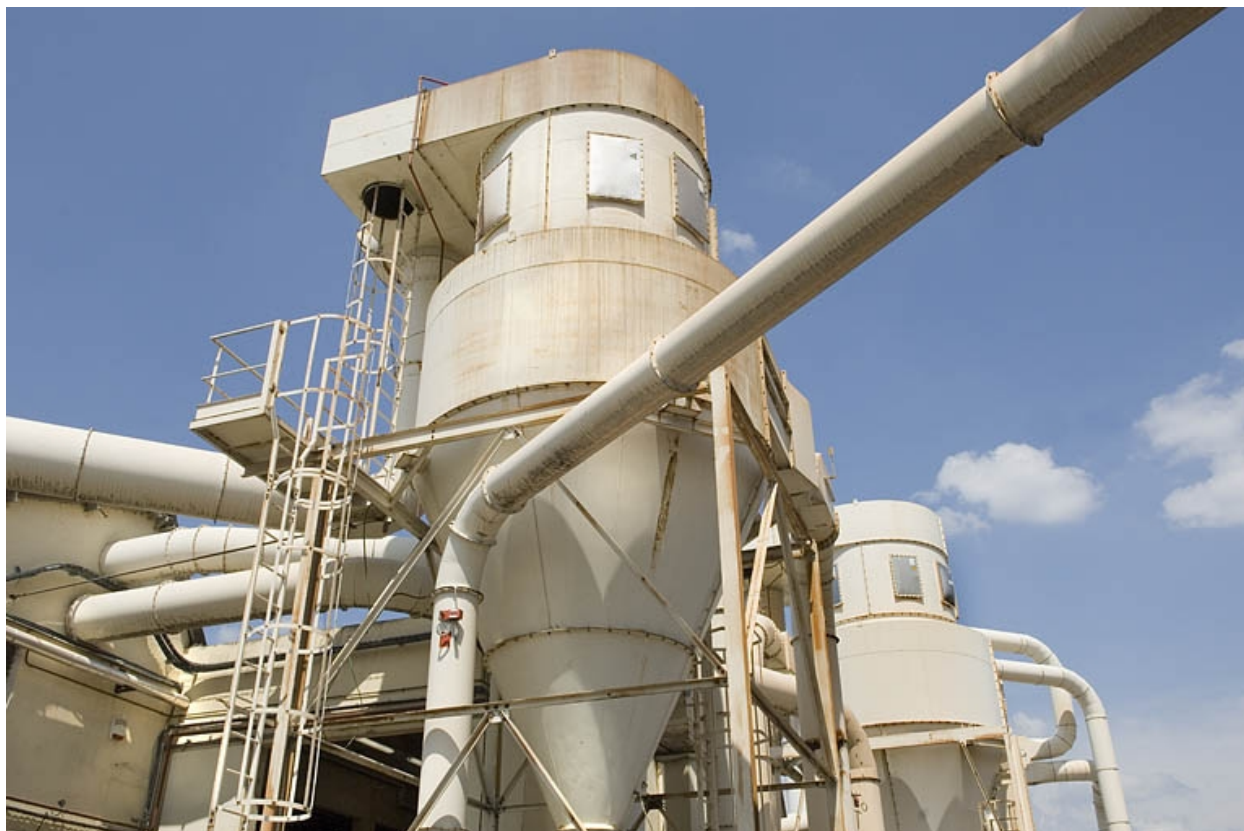
Silos de sciure.
