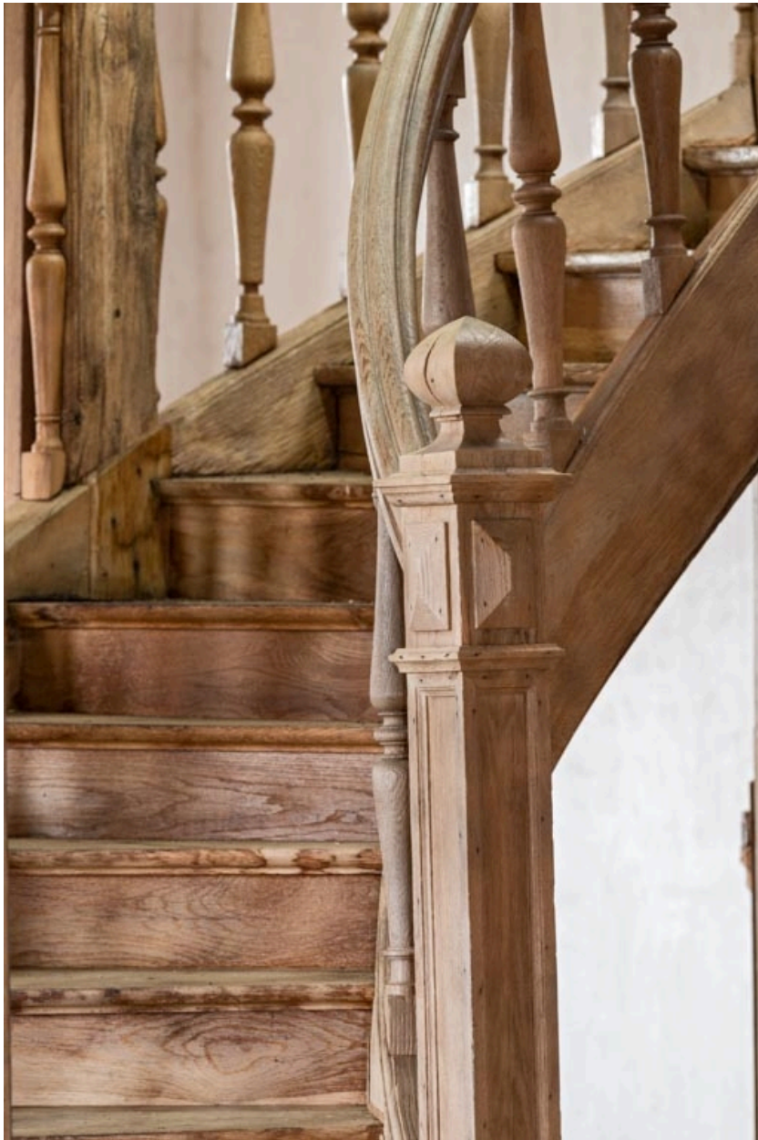
Partie supérieure du départ de rampe : décor.
