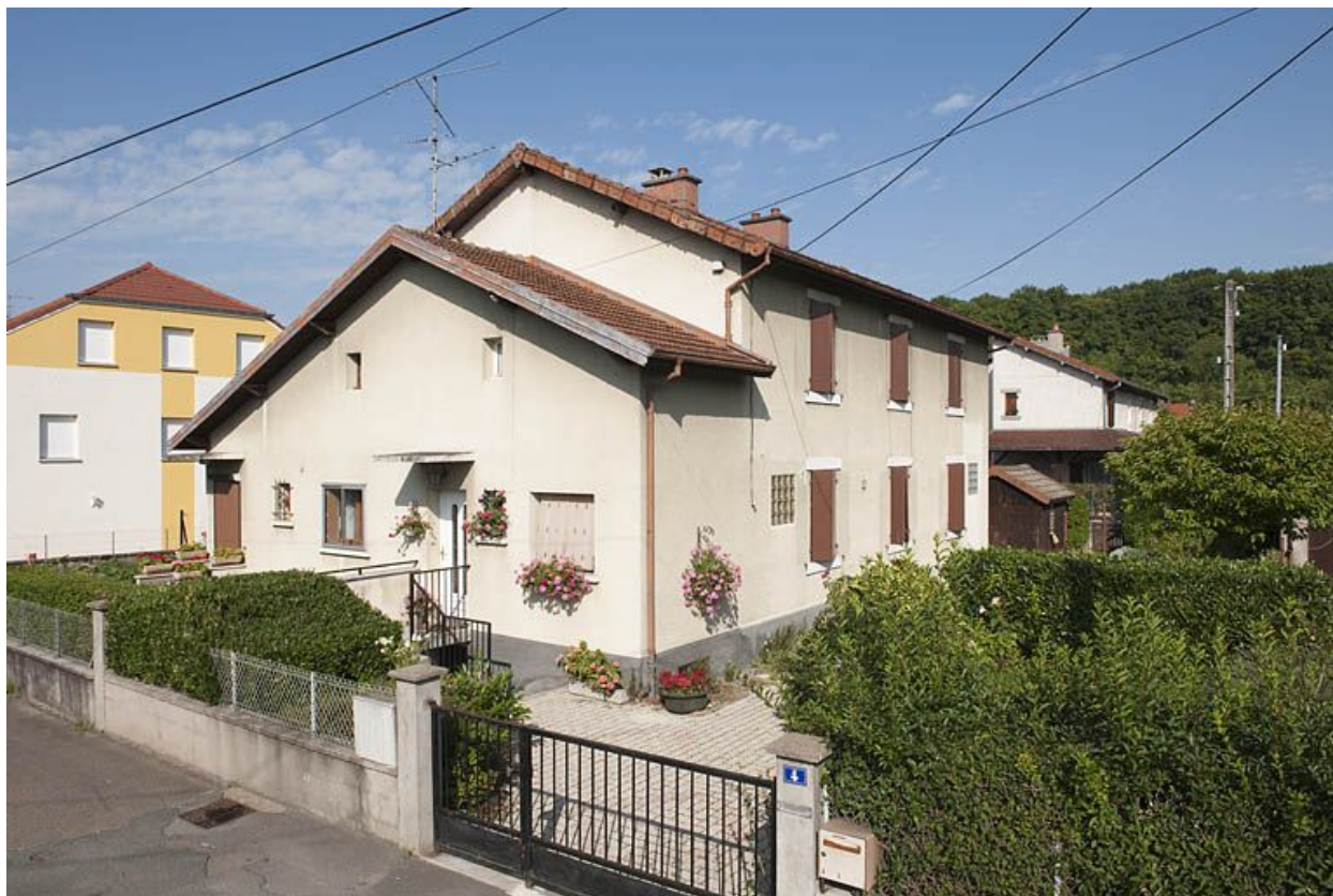
Habitation à 2-3 logements vue de trois quarts.
