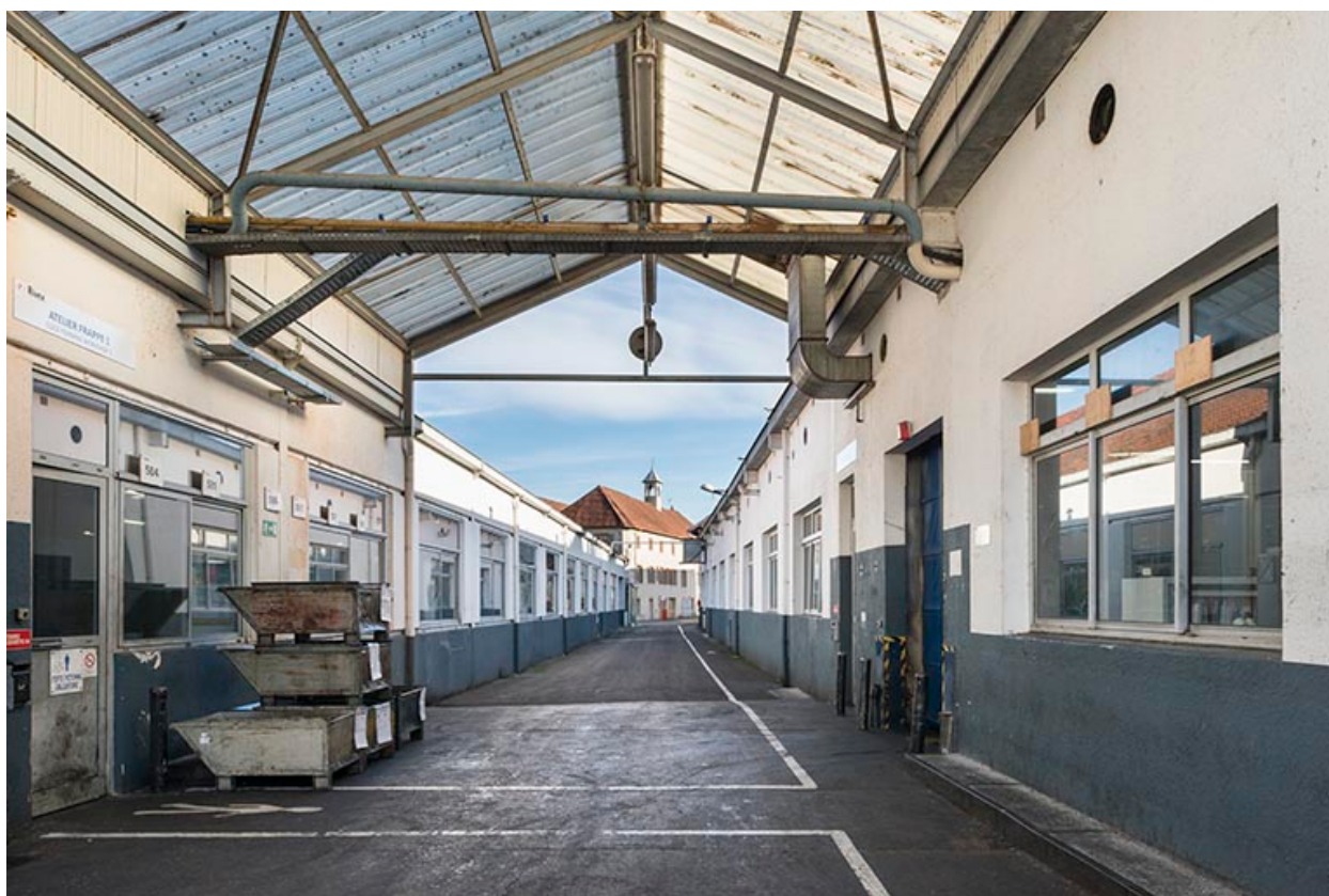
Passage couvert entre deux ateliers.
