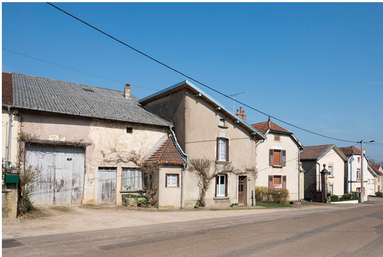
Vue générale, Grande rue.
