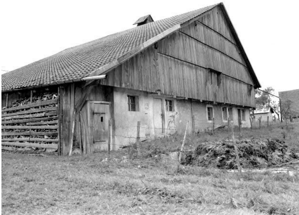
Façades postérieure et latérale droite.
