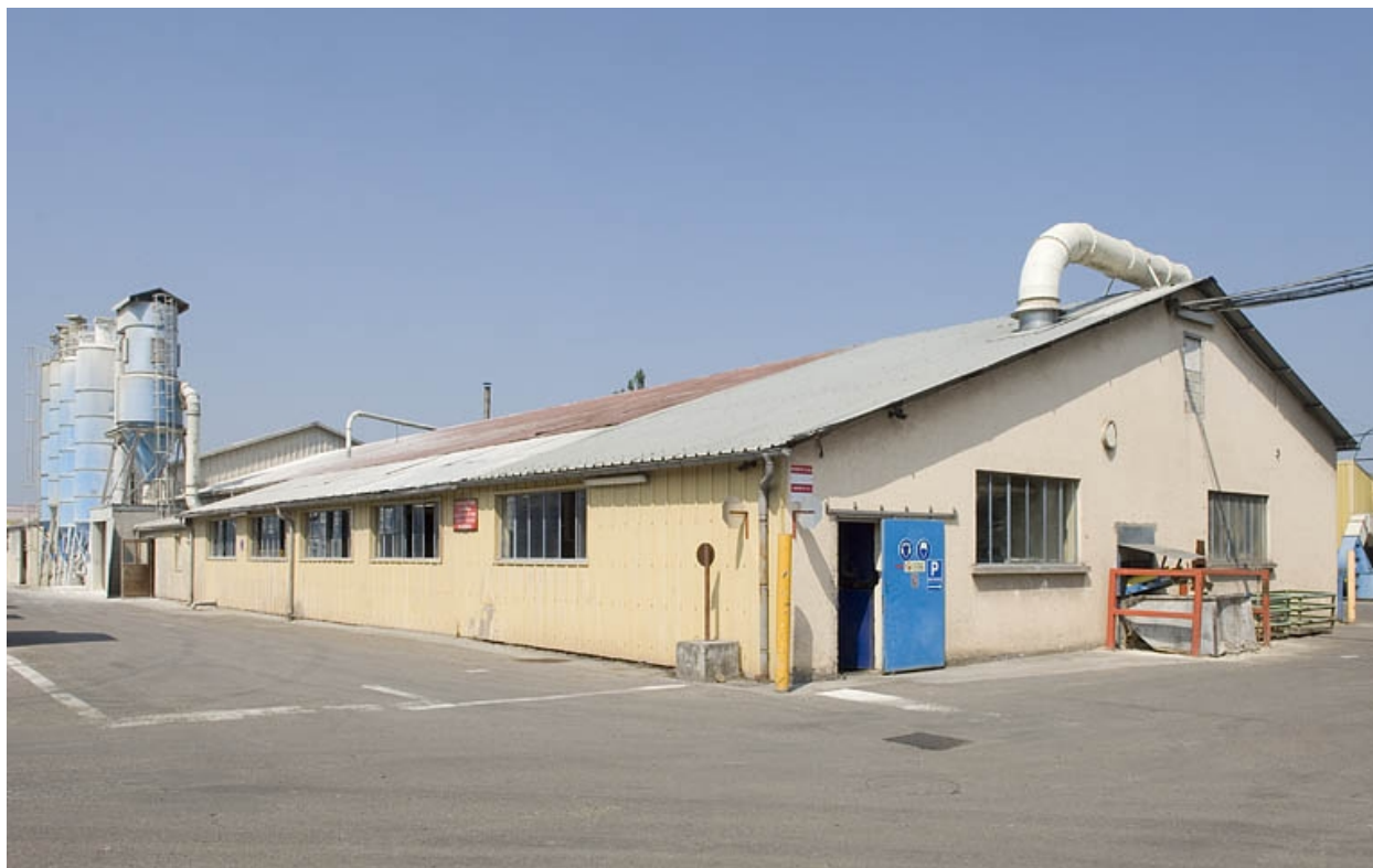
Atelier de fabrication sud.
