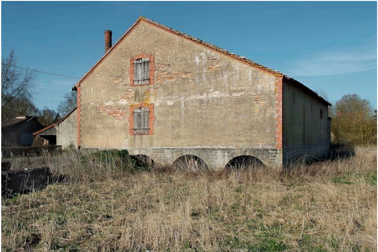
Bâtiment annexe au moulin principal, à usage d'entrepôt, construit sur arcades.
