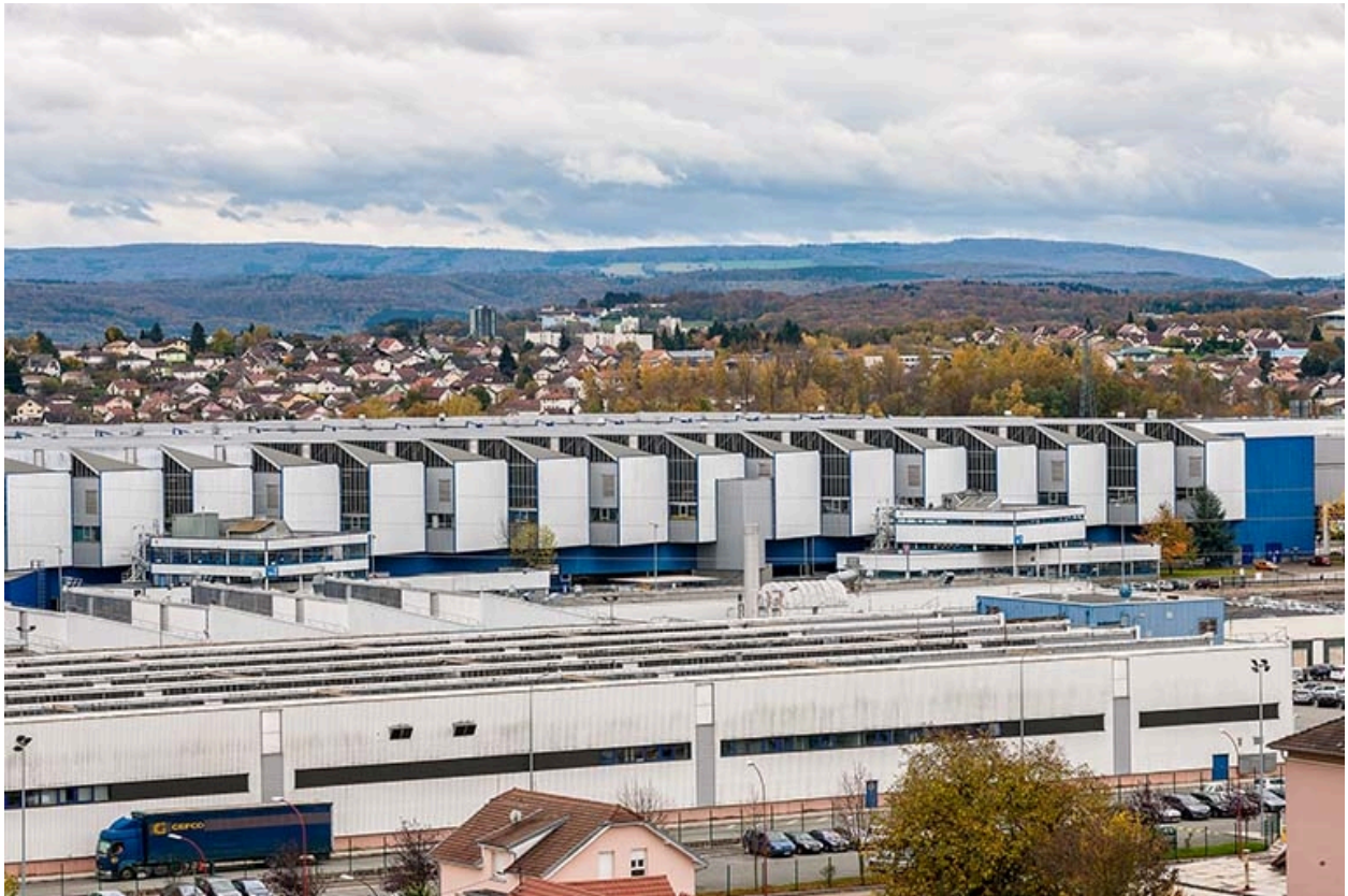
Ateliers sud (montage).
