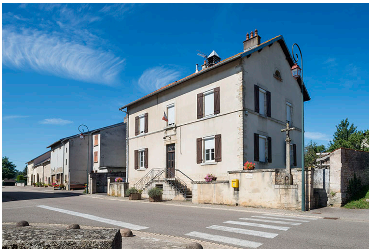
Vue d'ensemble de la maison commune.
