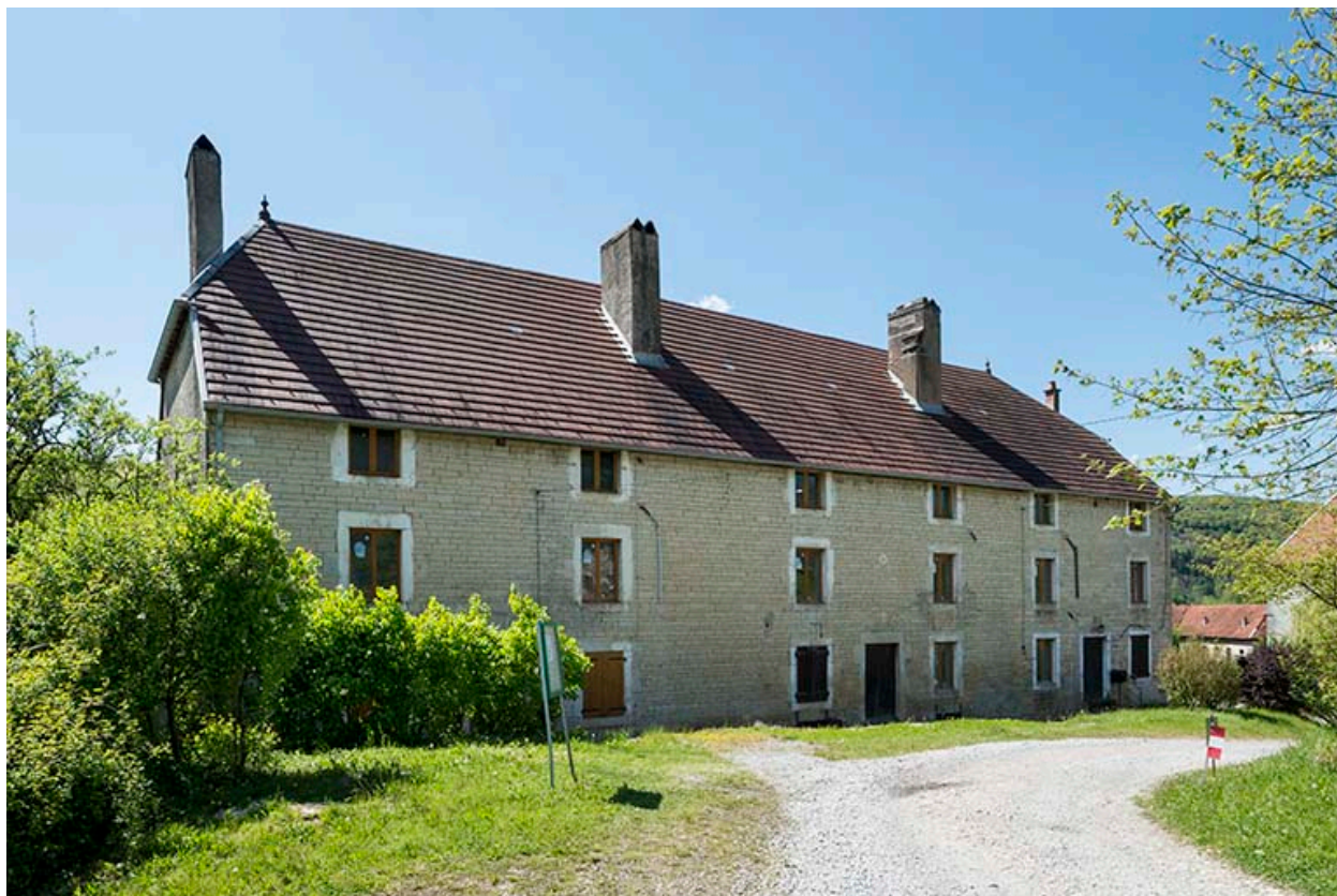
Logement ouvrier ouest. Façade sur cour.
