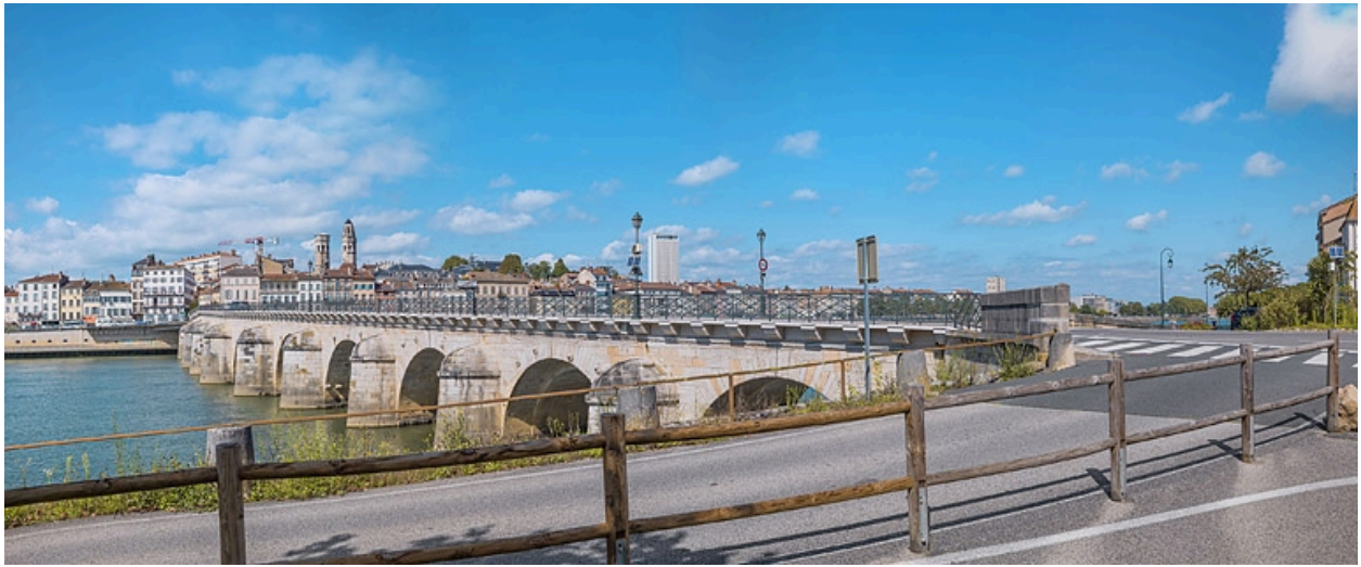
Vue d'ensemble du pont, d'aval et depuis la rive gauche.
