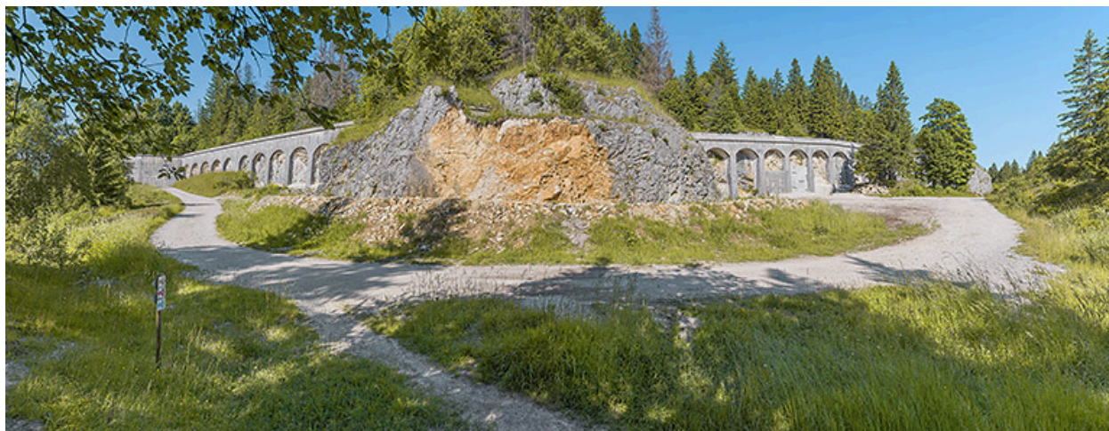
Front sud-ouest : bastion et une partie du mur d'enceinte.
