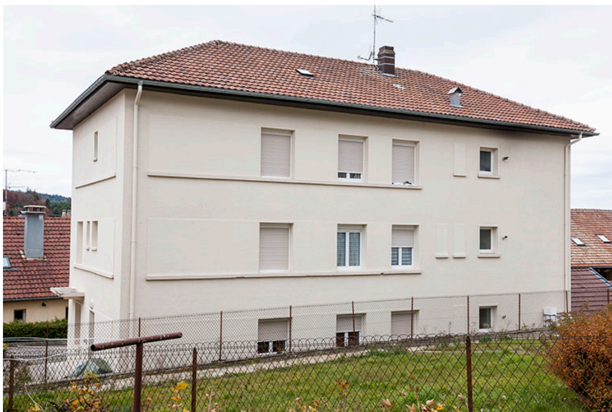
Usine : façades postérieure et latérale droite.
