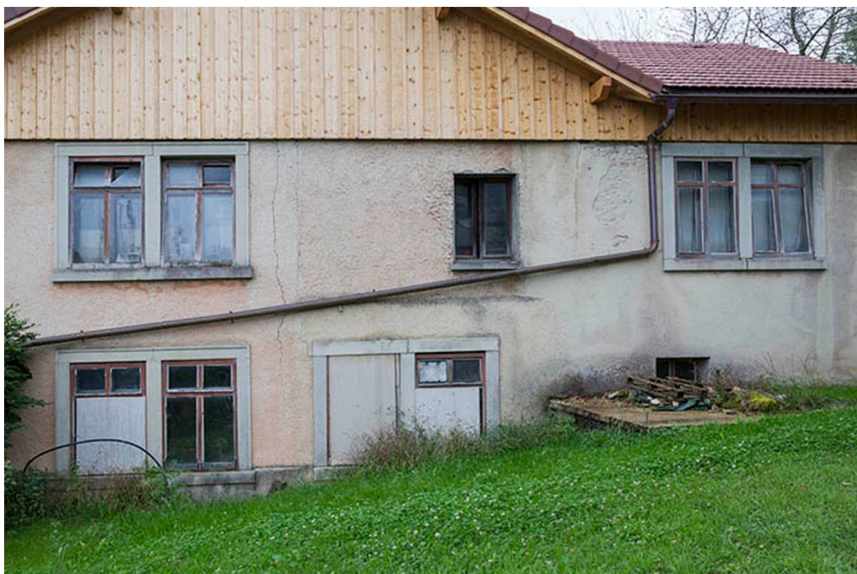
Usine : façade latérale droite.
