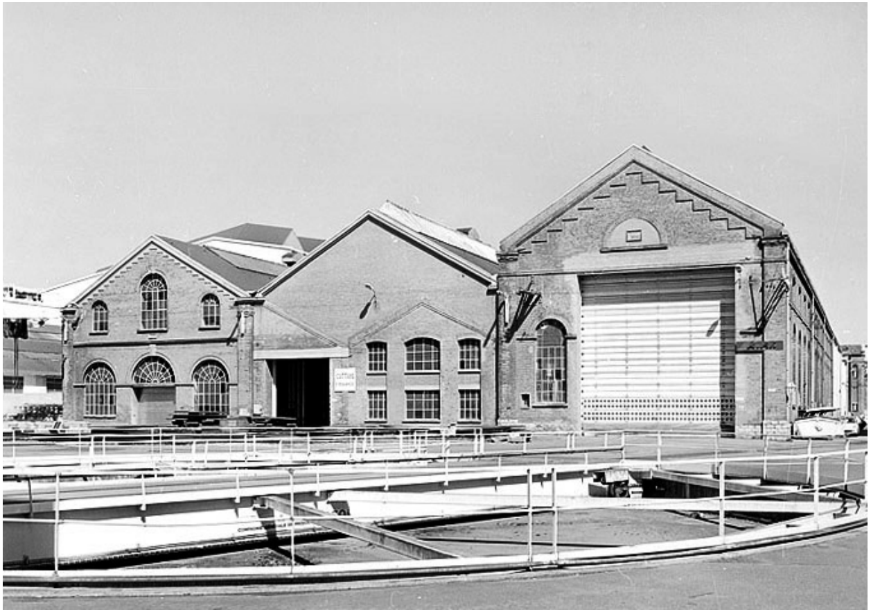
Vue de face des pignons des ateliers de métallurgie.
