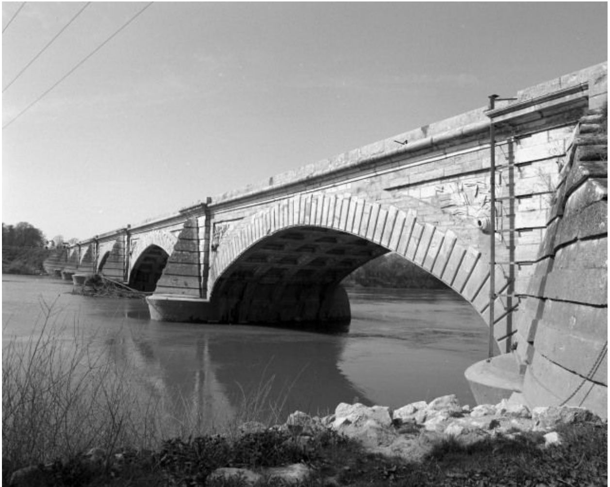
Vue d'ensemble rapprochée, en amont.
