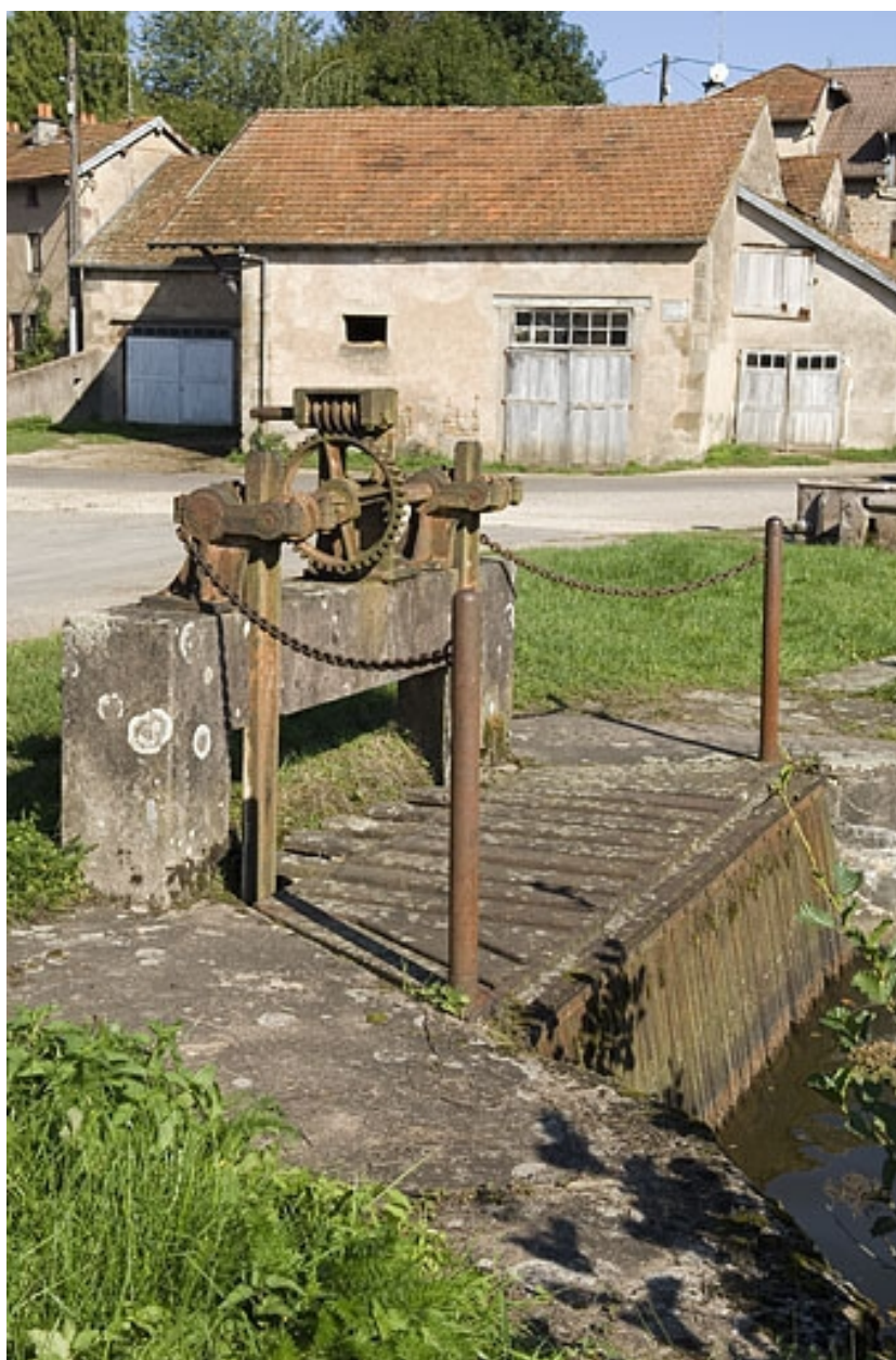
Vanne de prise d'eau de l'étang.
