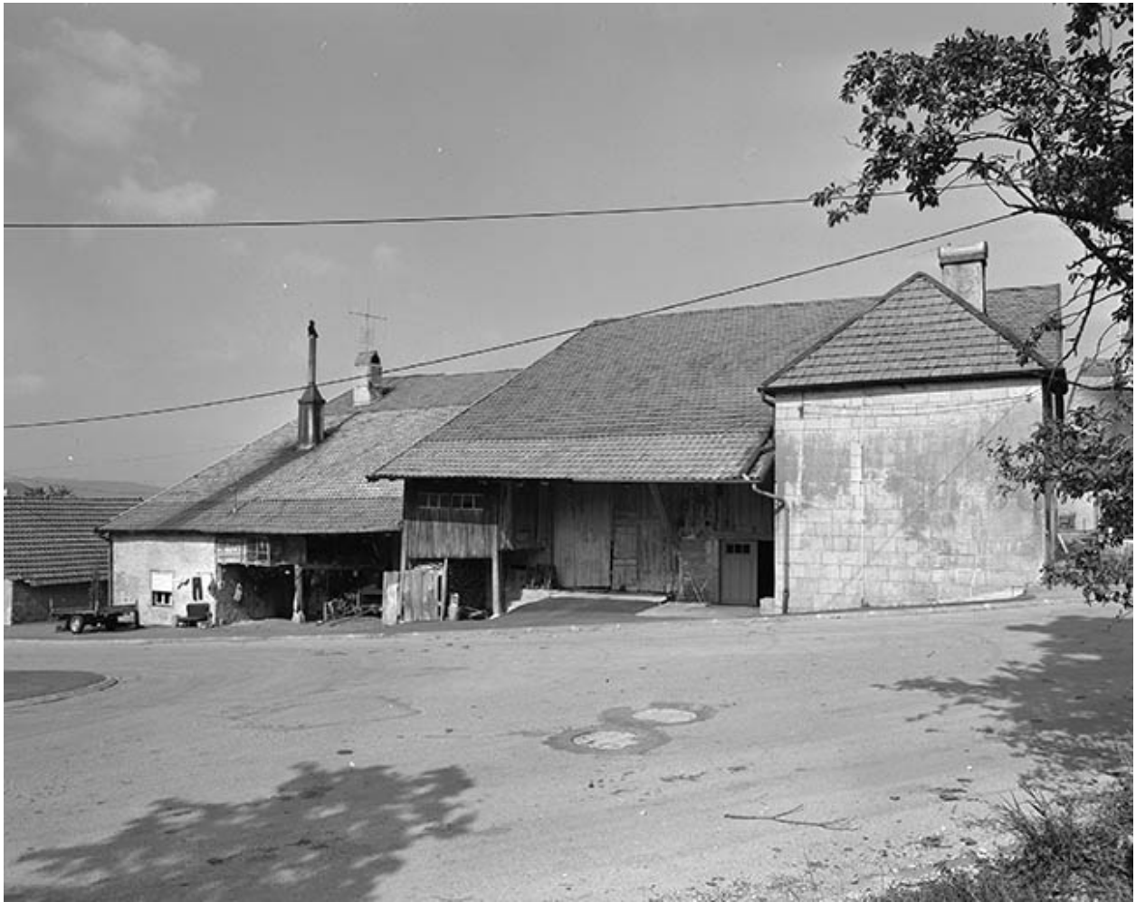
Ferme située 44-46 rue des Châteaux d'Eau : vue d'ensemble.
