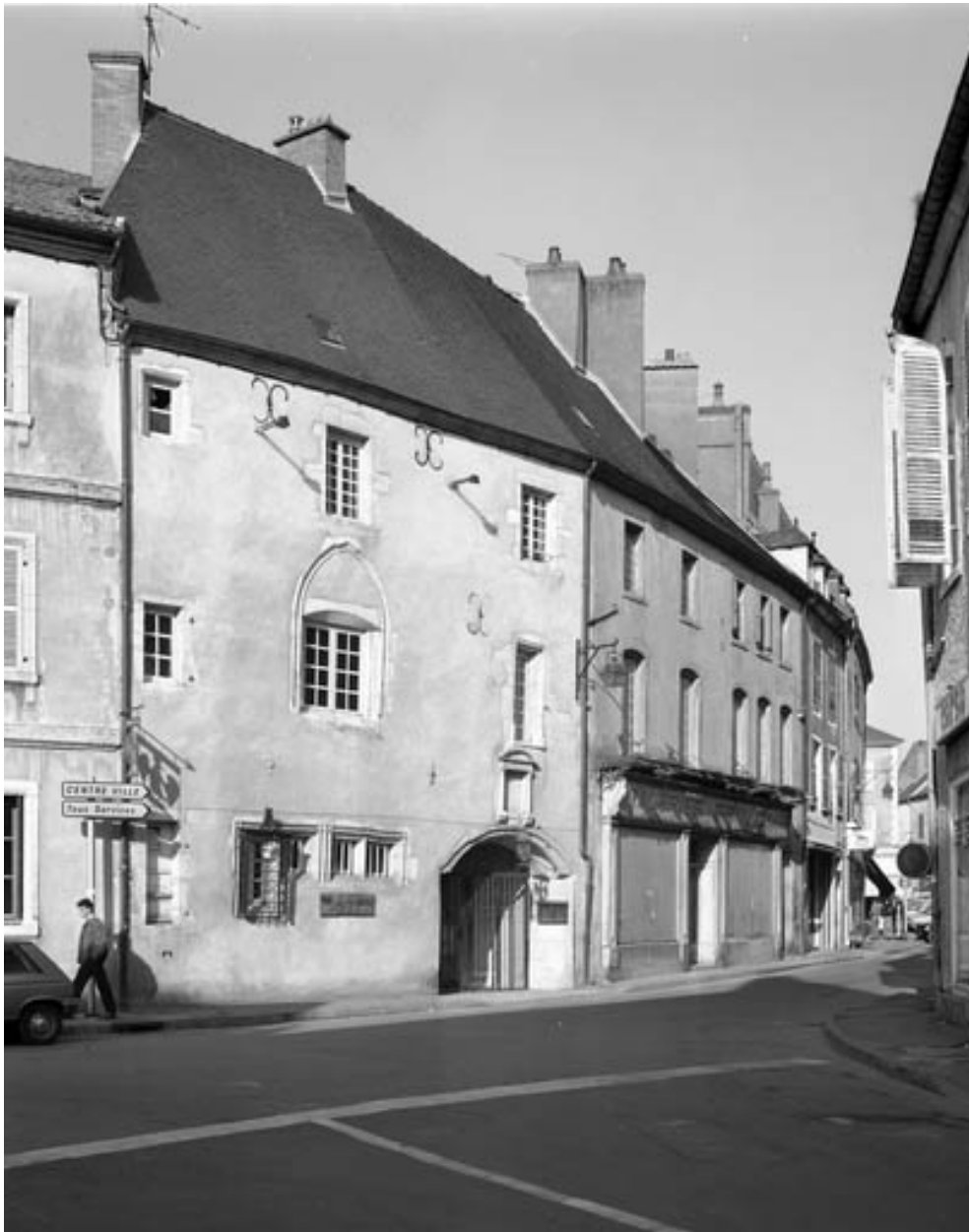
Façade antérieure : partie droite, vue rapprochée.
