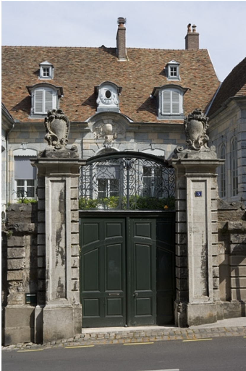
Vue d'ensemble du portail d'entrée depuis la rue.
