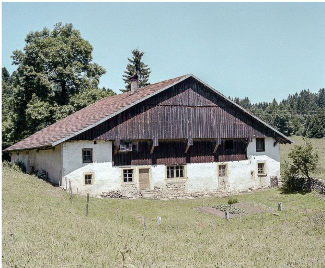
Façades antérieure et latérale droite.
