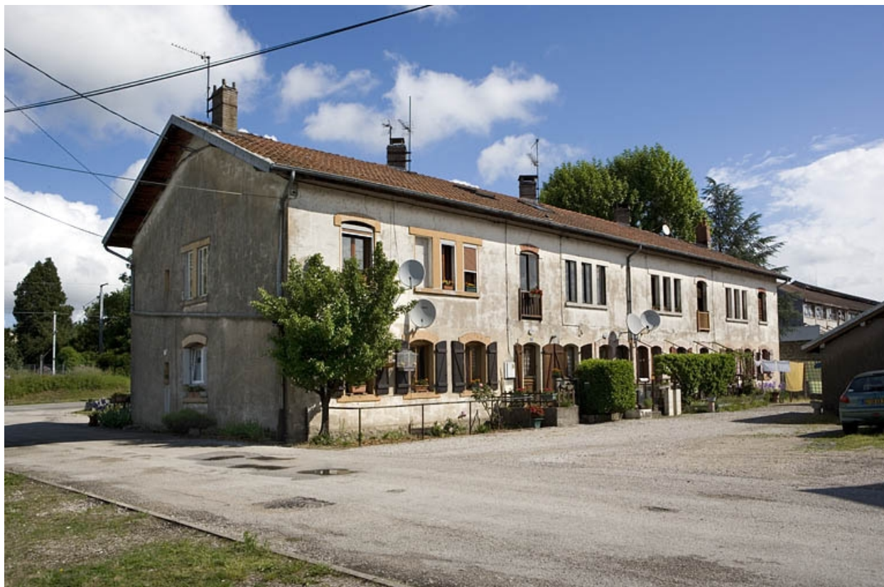
Cité ouvrière. Façade postérieure du logement situé 19 au 25 rue Weibel.
