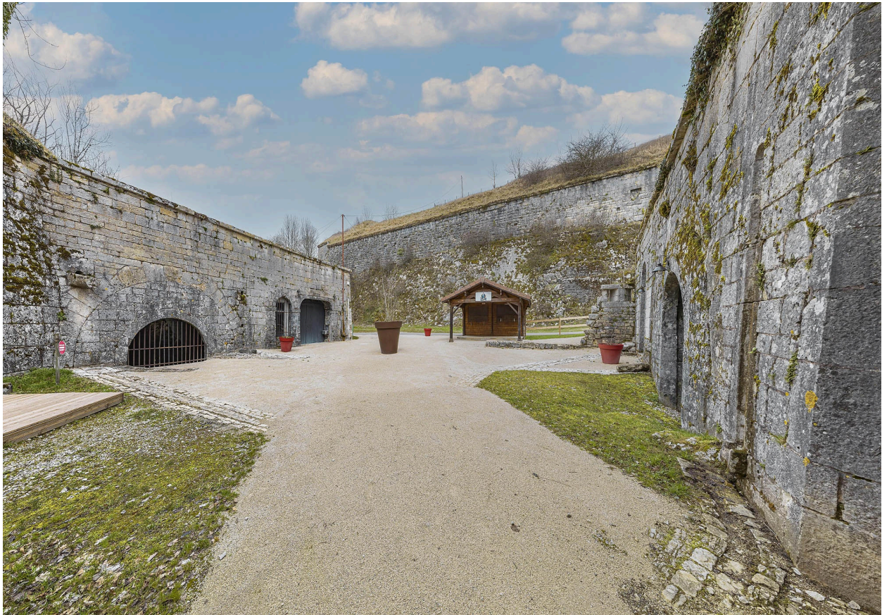
Vue de la cour intérieure.
