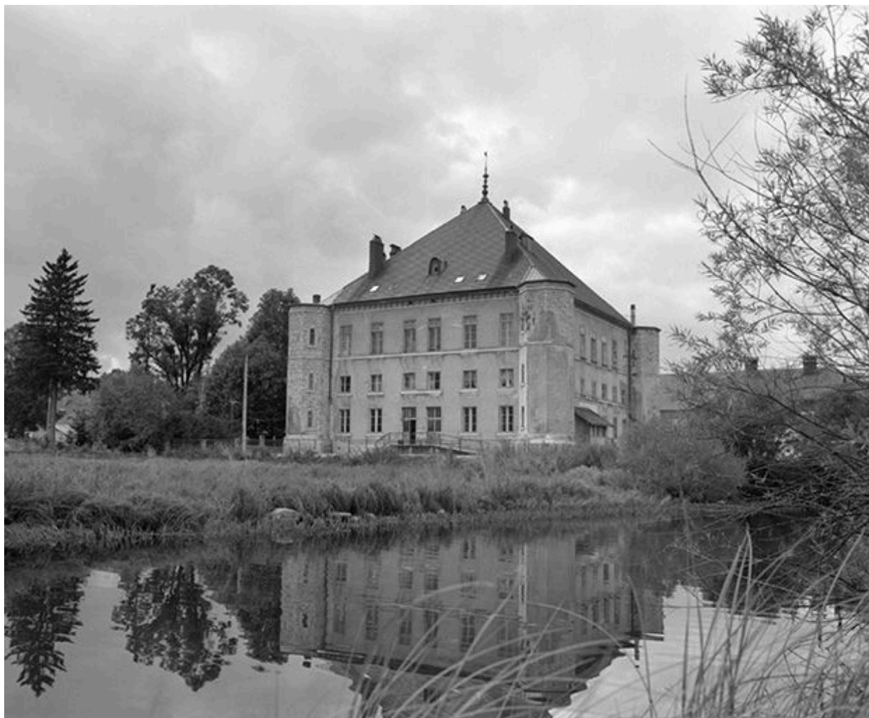
Façade postérieure et latérale gauche.
