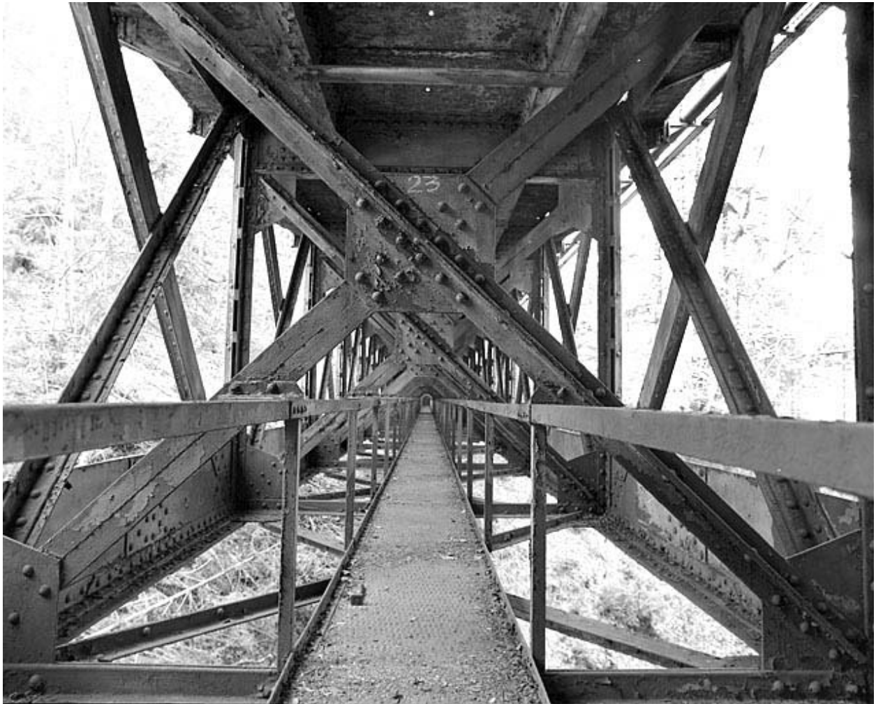
Viaduc : passerelle sous le tablier.
