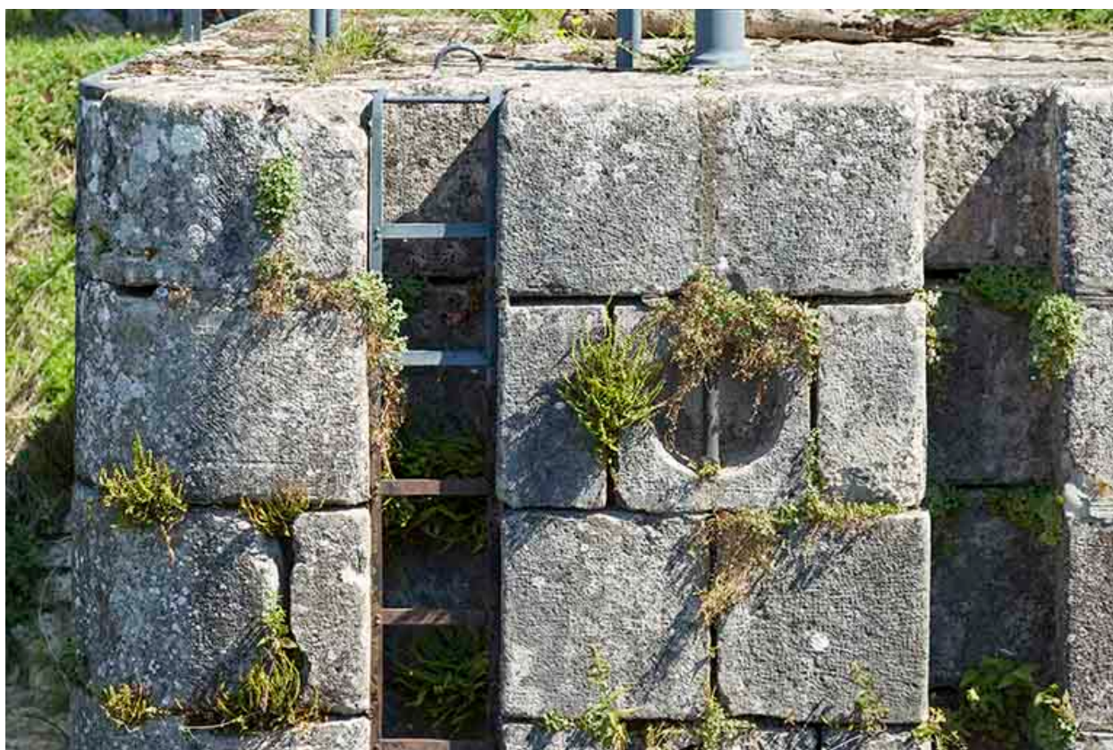
Rainure à batardeau (portière).
