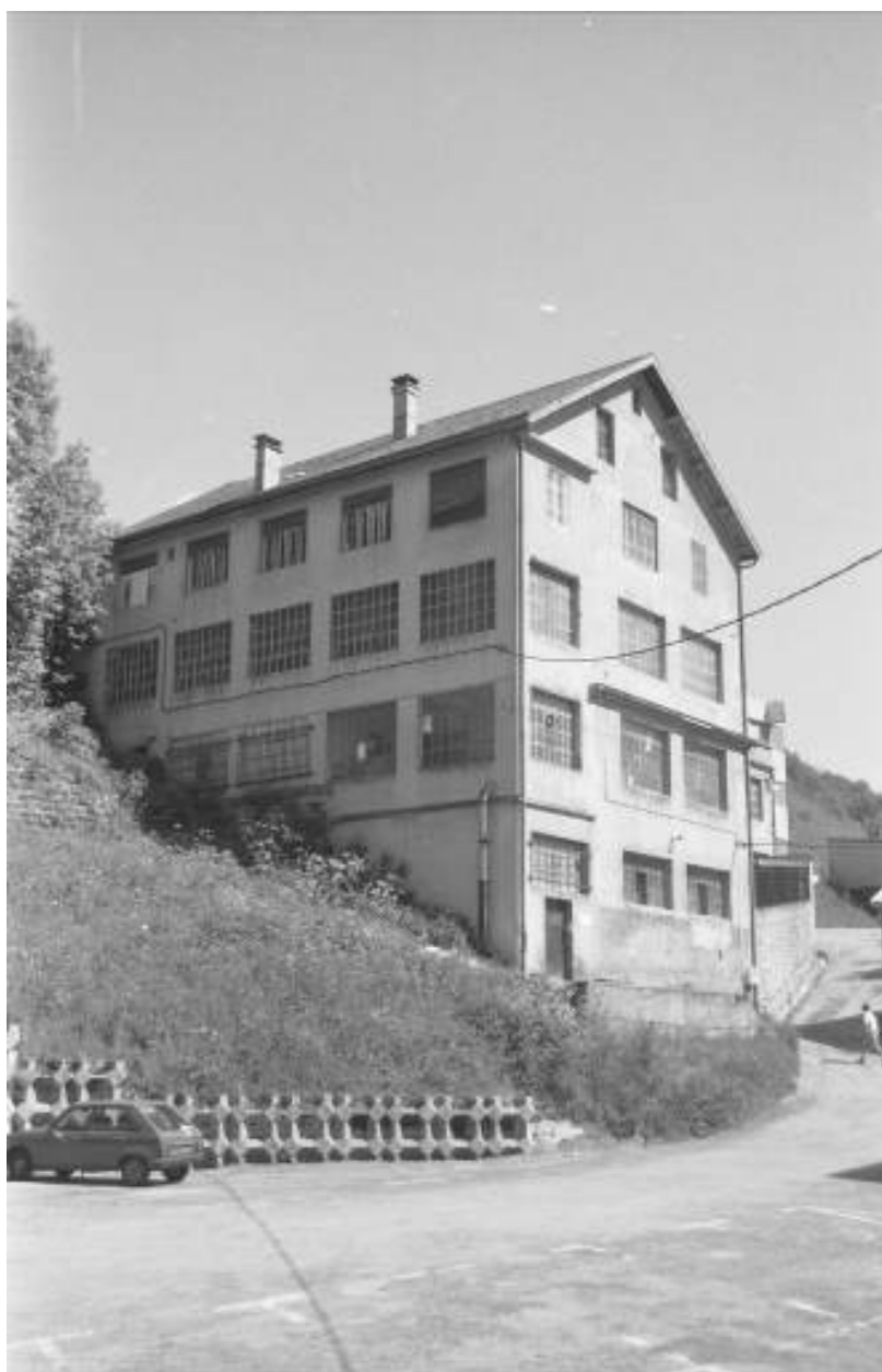
Façades postérieure et latérale droite.
