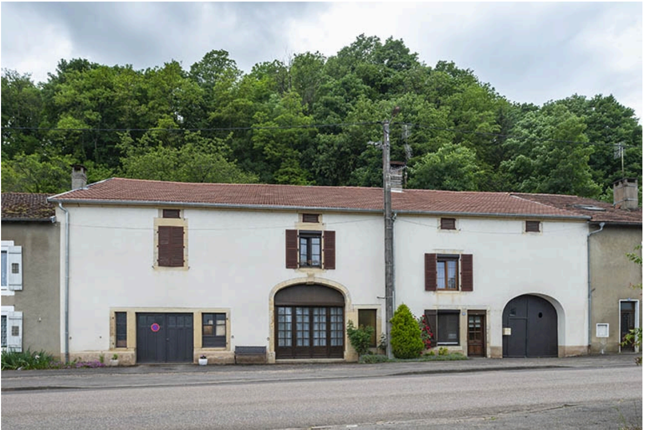
Façade de la maison ferme à cinq travées du n° 98 de la rue Thiers.
