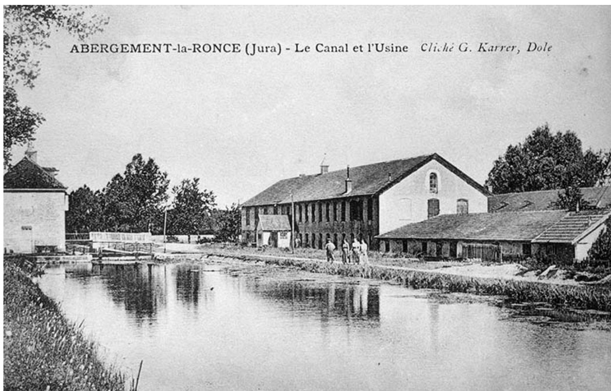
Abergement-la-Ronce (Jura) - Le Canal et l'Usine.
