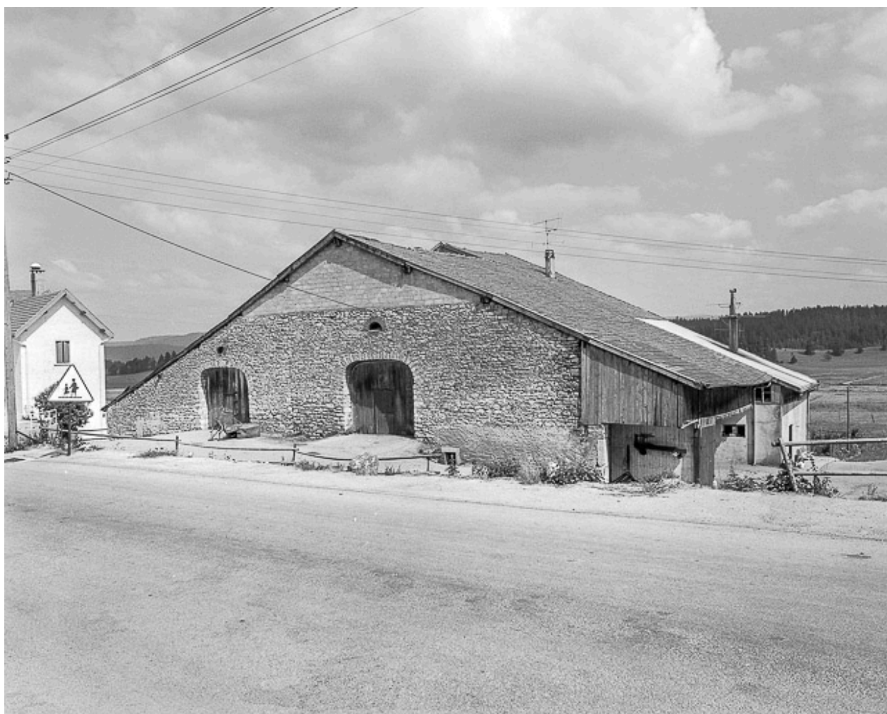
Pignon sur rue et mur goutterot d'une ferme.
