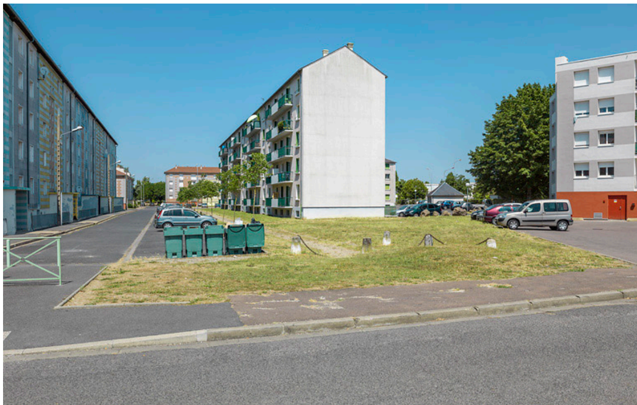
Bâtiment SIDEN, façades postérieure ouest et latérale sud.
