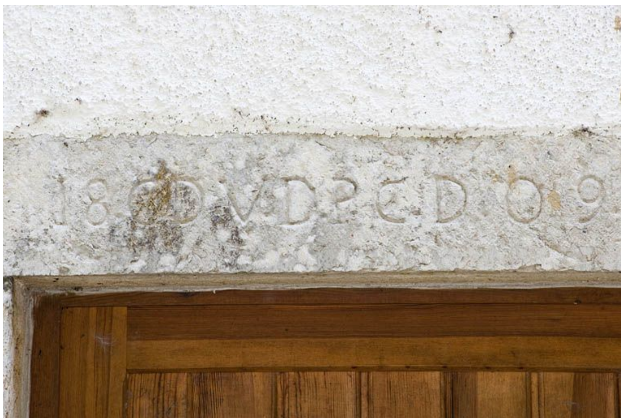
Façade nord du moulin. Linteau gravé.
