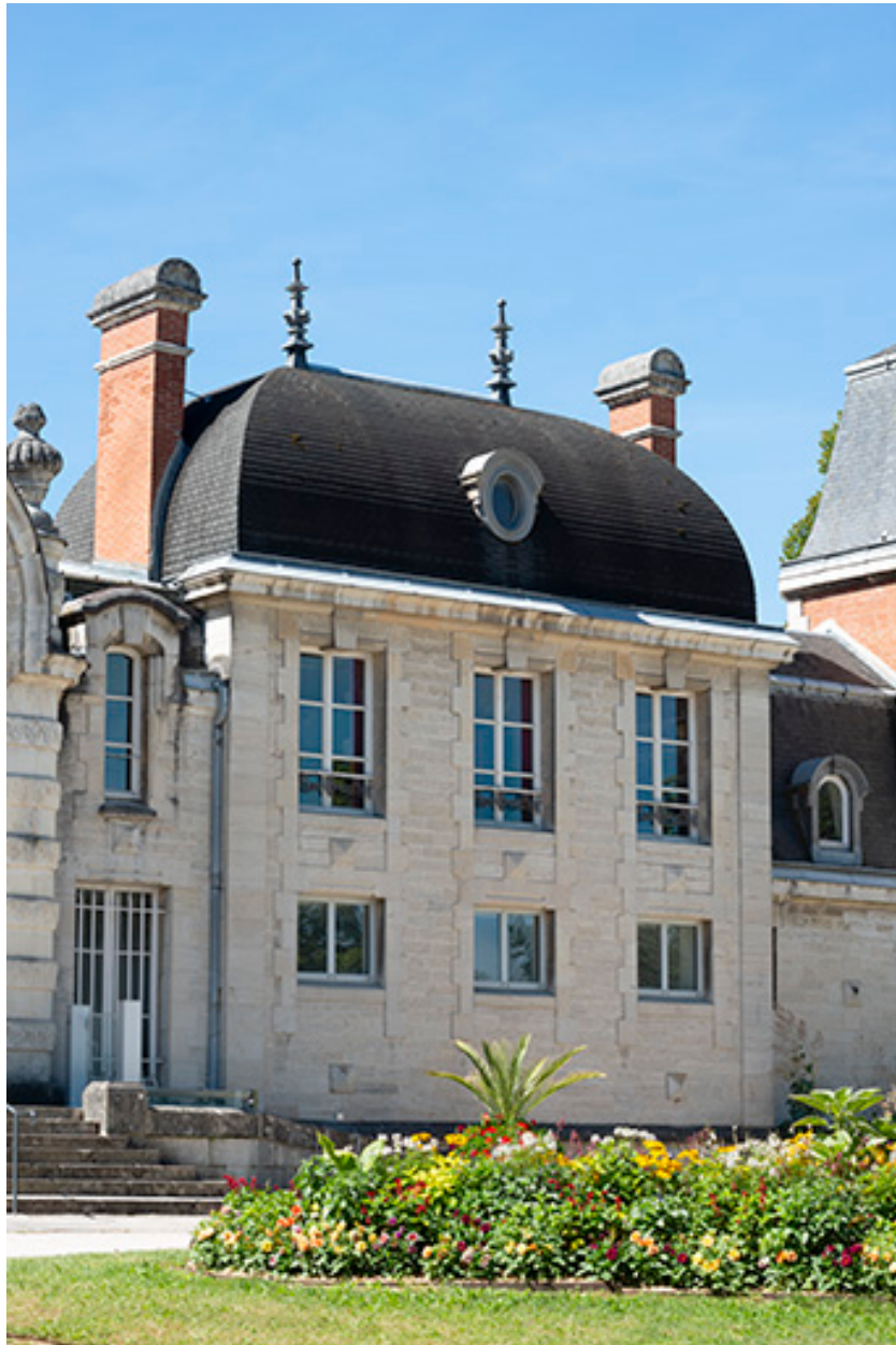
Façade principale, pavillon occidental.
