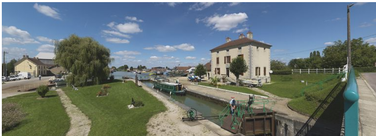
Ensemble du site vu d'aval.
