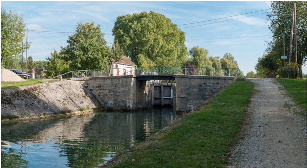
Vue d'ensemble du site, prise d'aval.
