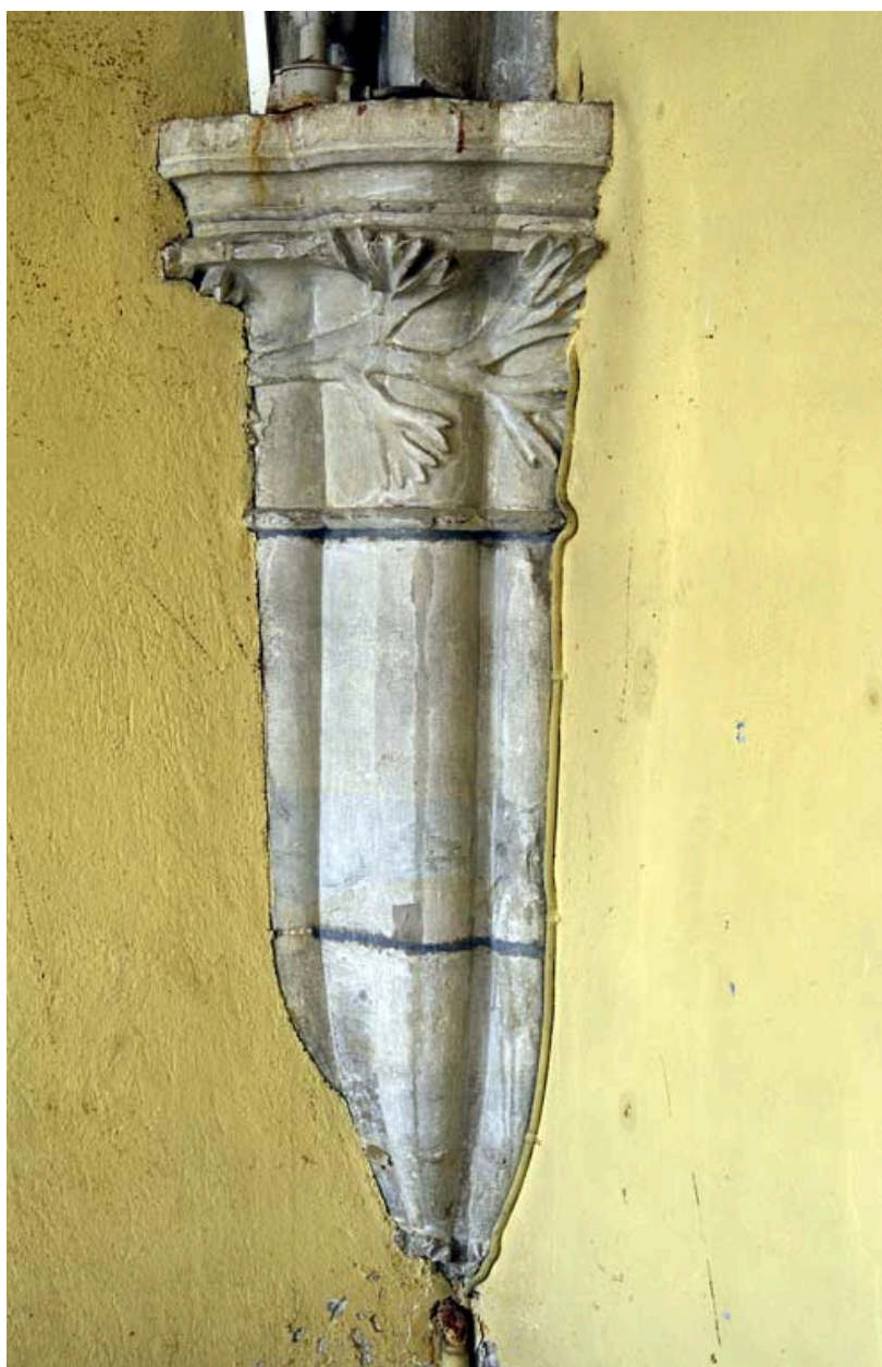
Bâtiment du réfectoire : culot fasciculé à chapiteau feuillagé (13e siècle).
