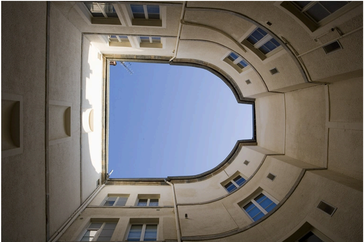
Vue des bâtiments autour de la cour en contre-plongée.
