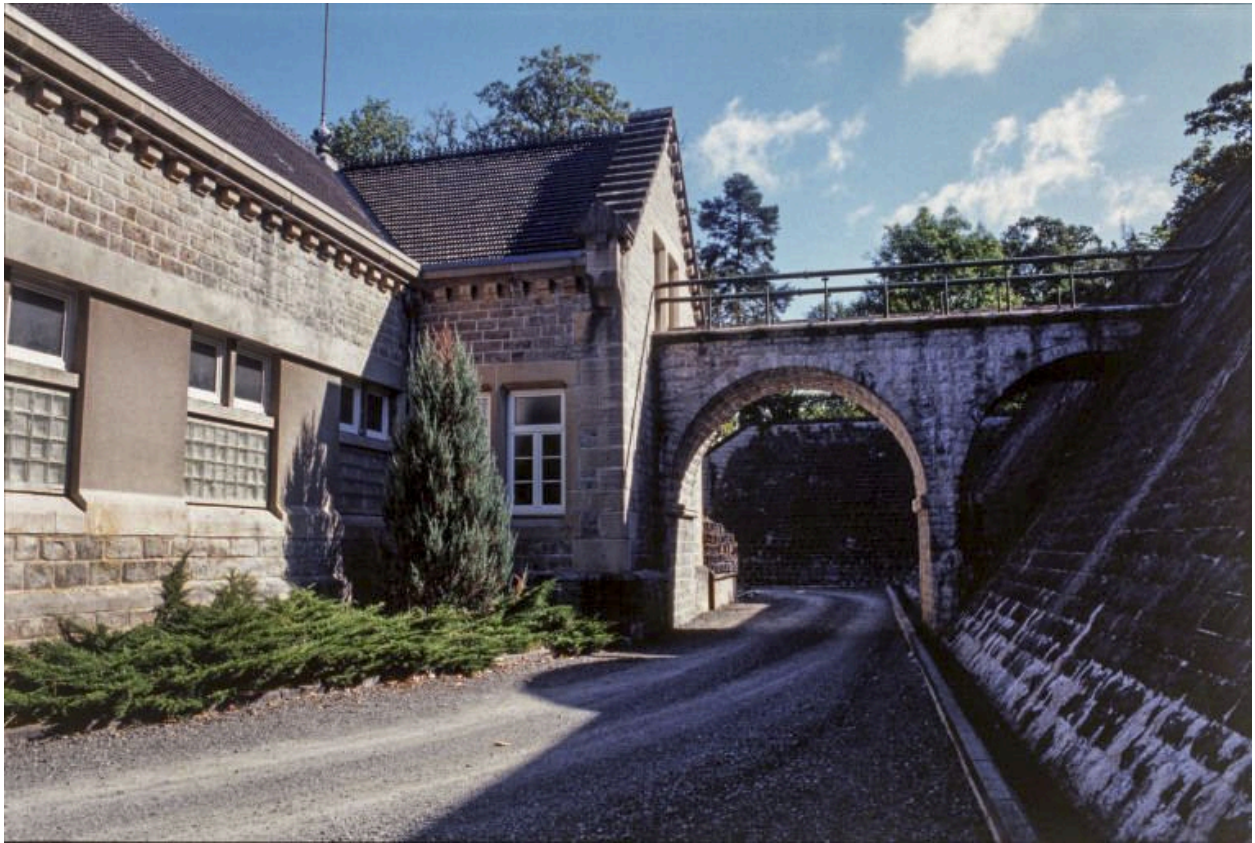
Élévation postérieure et pont-aqueduc.
