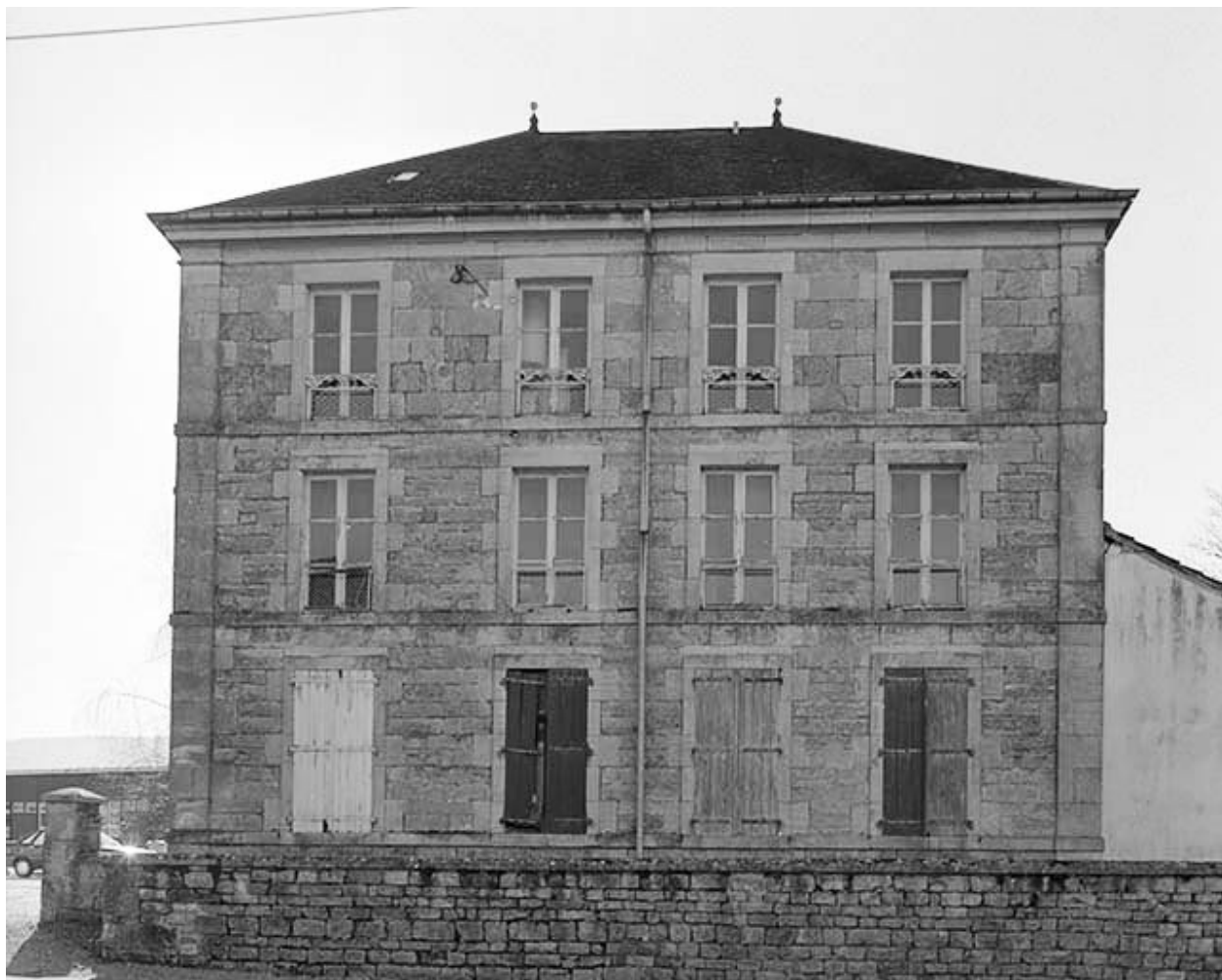
Façade antérieure du logement d'ouvriers.
