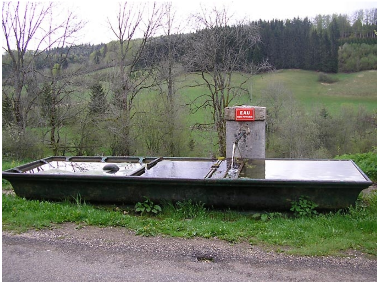
Fontaine située au lieu-dit La Ruine.
