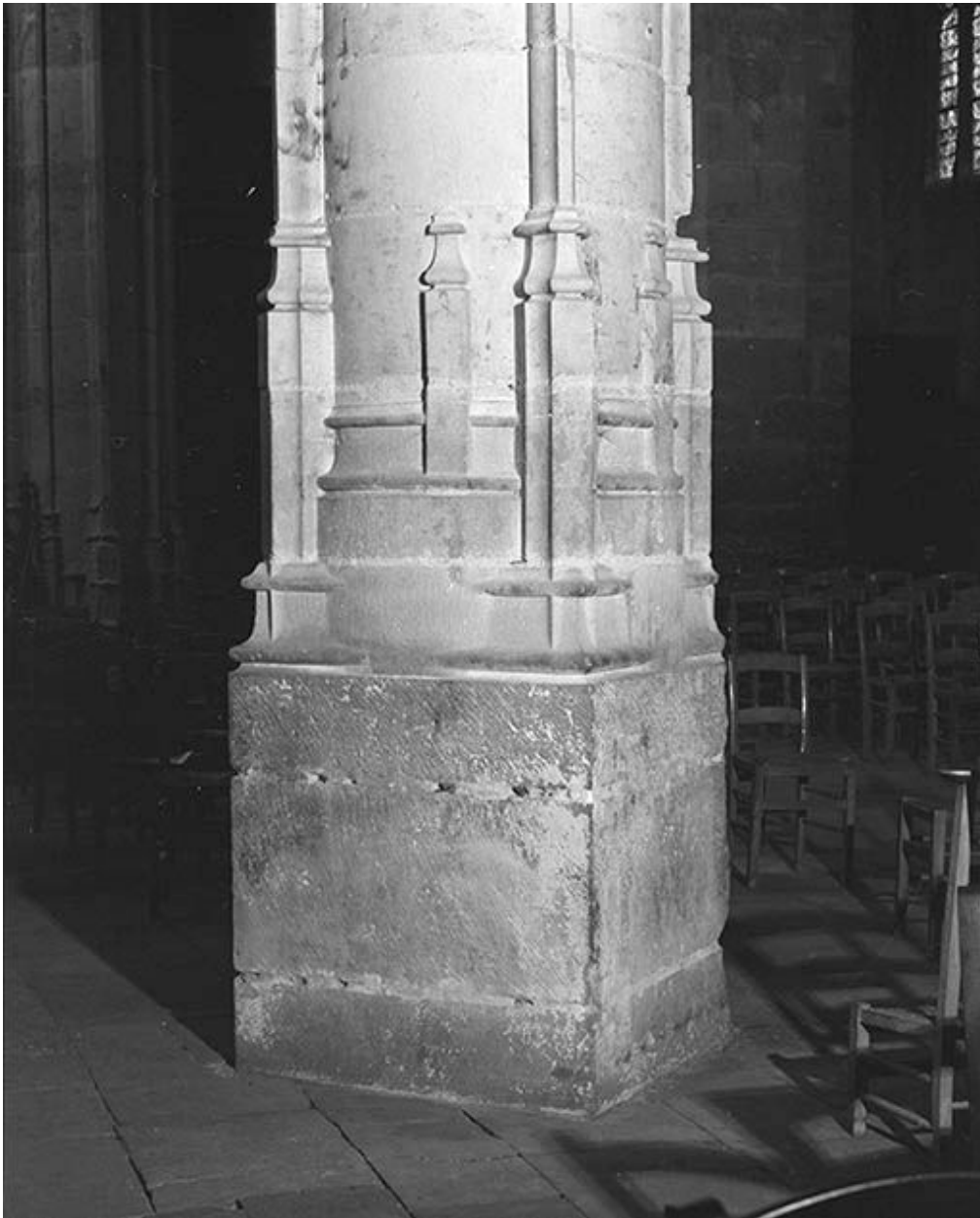
Collatéral droit, 3e travée : base du pilier antérieur gauche.
