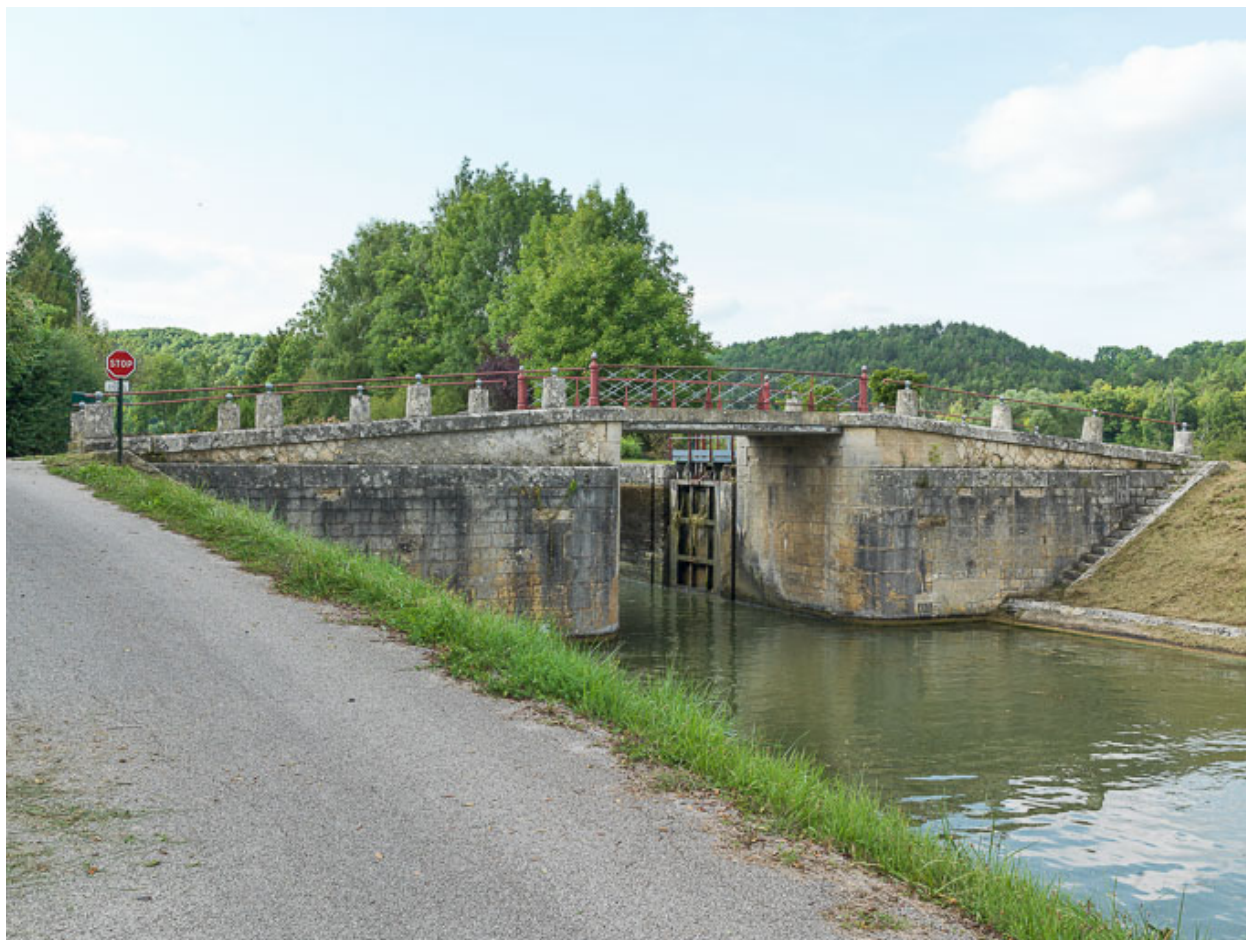
Vue d'ensemble du pont.
