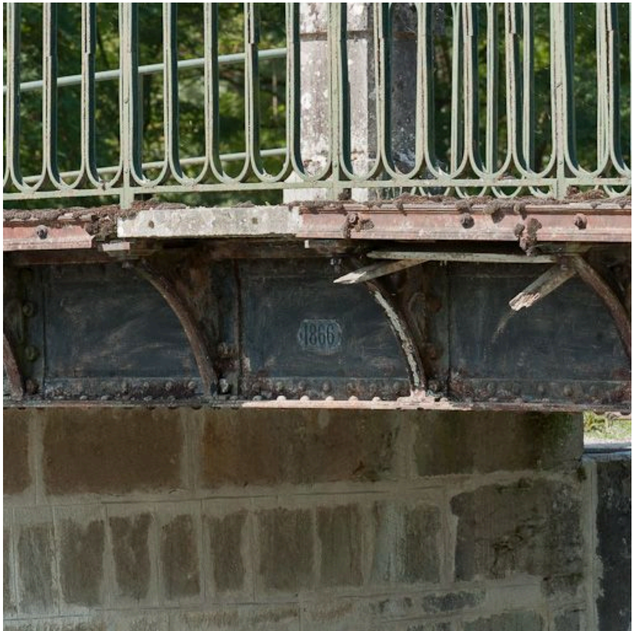
Détail du pont sur écluse.
