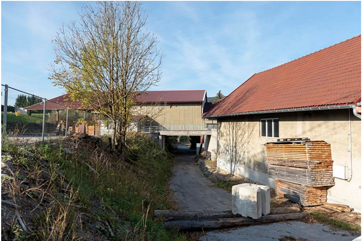
Atelier récent et chemin, depuis l'est.
