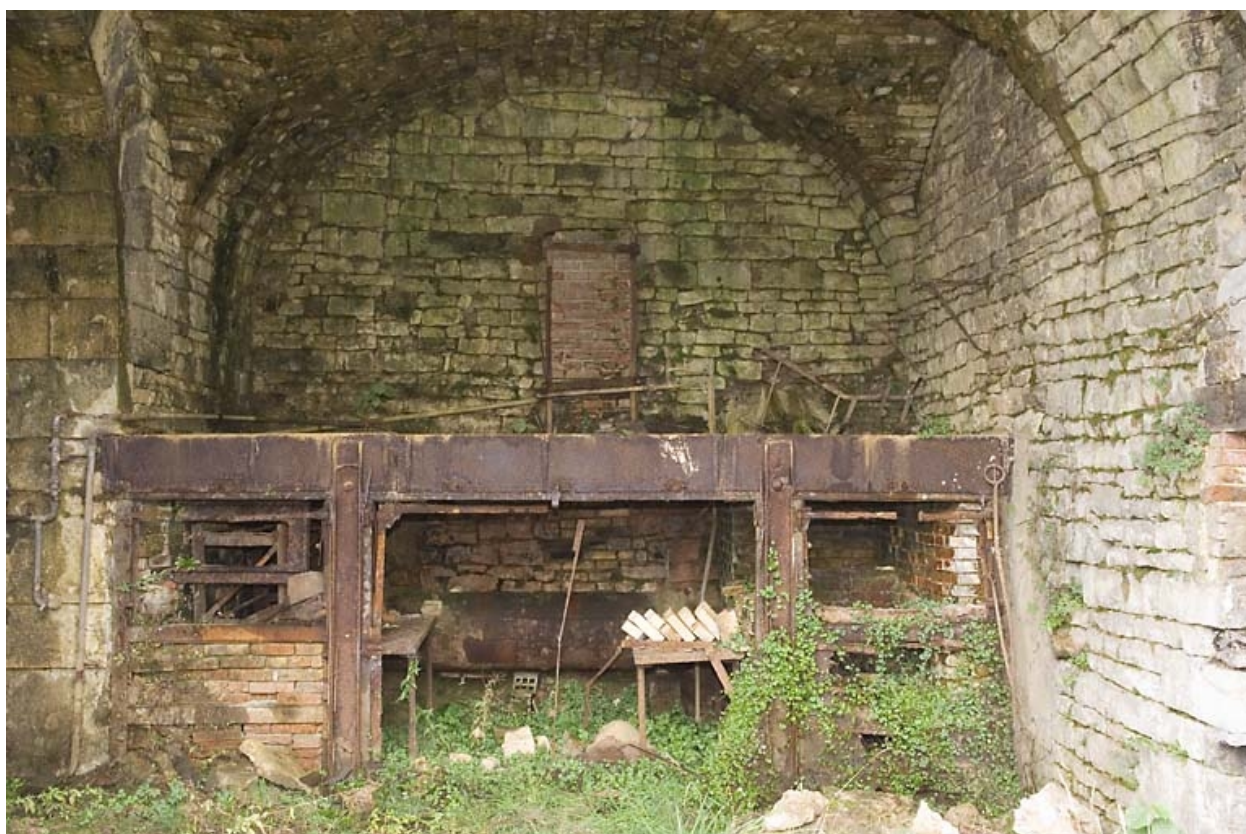
Salle des cubilots. Vestiges d'un four (?).
