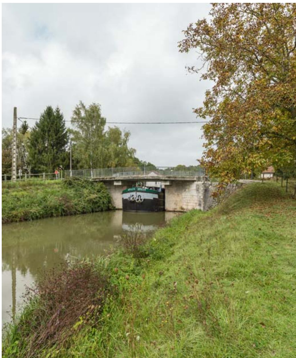
Vue d'ensemble du pont.
